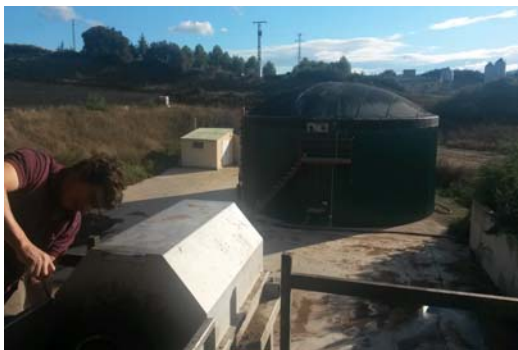
Quelle: BIOVEC. Kleinformatige AD-Anlage in Zaragoza (Spanien)
